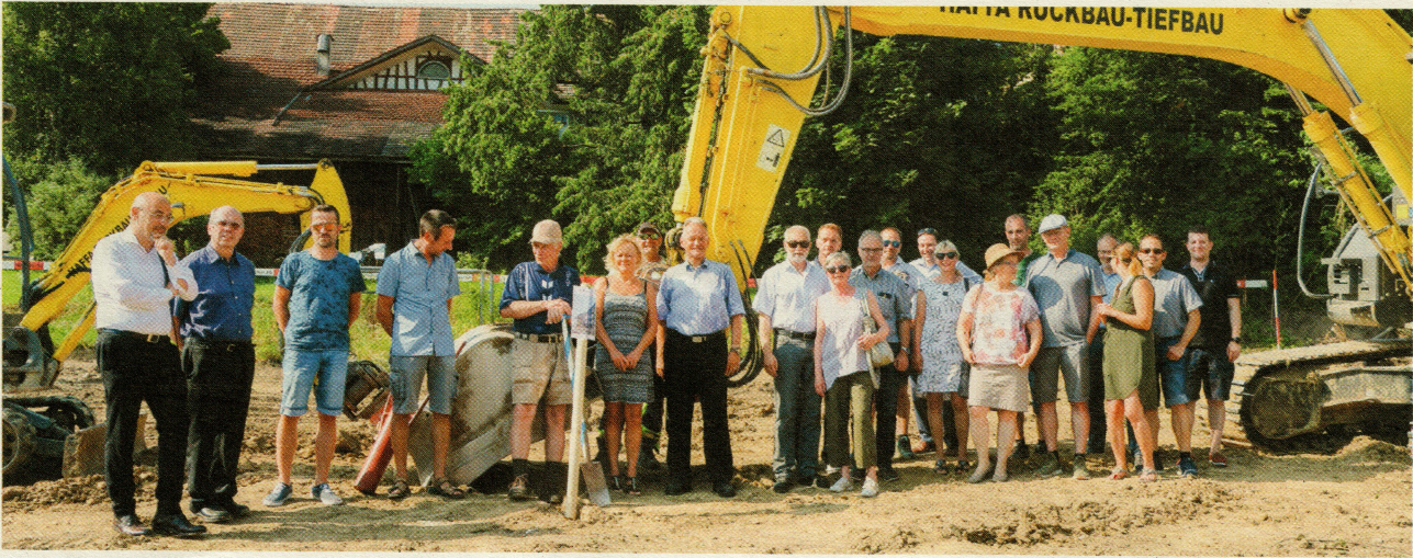
Spatenstich für die beiden Mehrfamilienhäuser an der Gartenstrasse 11 und 13.
